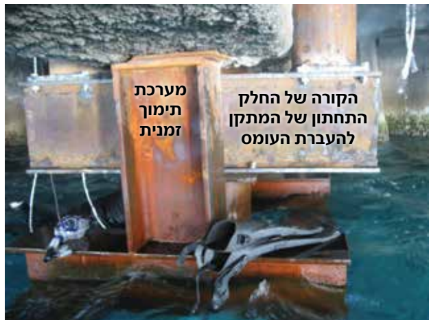
תמונה 4: מערכת תימוך זמנית והחלק התחתון של המתקן להעברת העומס
