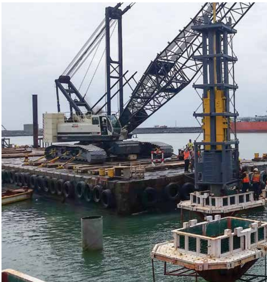
תמונה 1: ניסיון העמסה דינמי בפרויקט ימי – חברת גאודינמיקה
