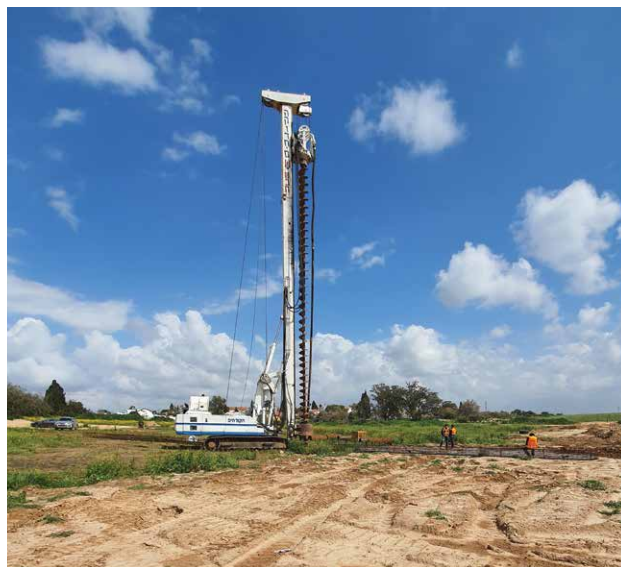
תמונה מס' 1: מכונת CFA לביצוע כלונסאות
