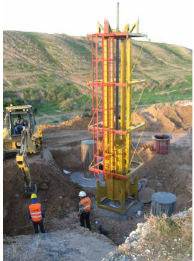
ניסיונות העמסה דינמיים להשגת אופטימיזציה וחיסכון בביסוס. חברת גיאודינמיקה
